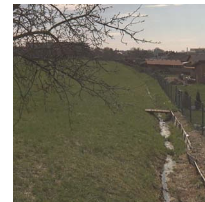
Stávající zatrávněná strouha - pohled severní
