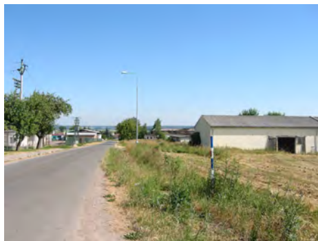
průjezdny úsek silnice III/32253
