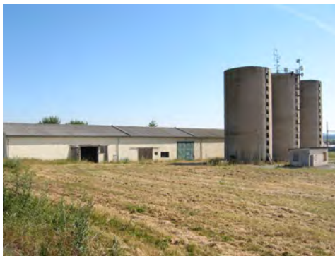
elektronické komunikační zařízení na zemědělských silech
