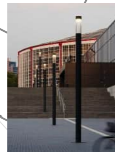
parková lampa BEGA výška: 500 cm povrchová úprava kov: vypalovaný lak matný, sklo: čiré
