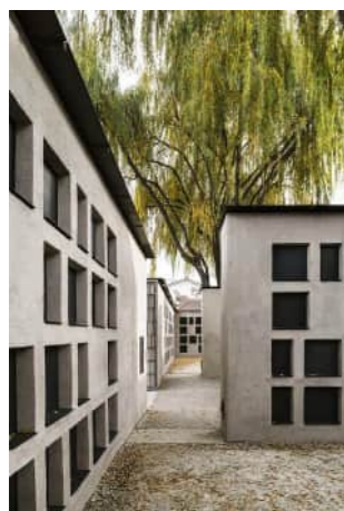
pietní místo s výklenky pro ukládání urn s popelem zemřelých (kolumbárium) s návazností na místo rozloučení a rozptylovou loučku
