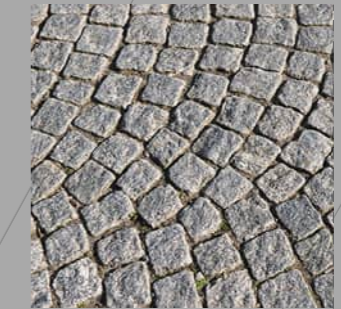
žulová kostka skládaná do vlašťovky velikost kostky 80 - 100 mm silnice ve zklidněném dopravním režimu
