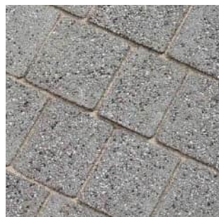
skládaná betonová mozaika tvoří veškeré exteriérové pochozí i pojezdové zpevněné plochy
