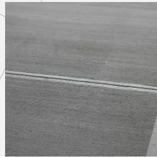
česaný betonový povrch osové pěší komunikace hřbitova komunikace pro pěší
