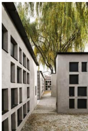
pietní místo s výklenky pro ukládání uren s popelem zemřelých (kolumbárium) s návazností na místo rozloučení a rozptylovou loučku
