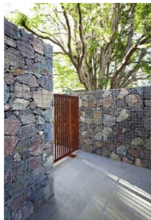
gabionové opěrné stěny tvořící oplocení hřbitova, doplněné o kortenové prvky (popis, vrátka) nerezové síťované koše vyplněné skládaným kamenivem
