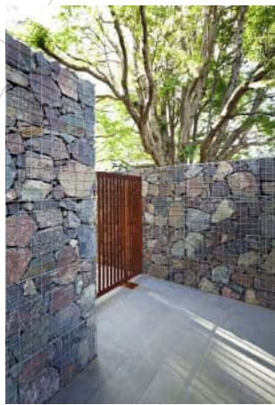
gabionové opěrné stěny tvořící oplocení hřbitova, doplněné o kortenové prvky (popis, vrátka) nerezové síťované koše vyplněné skládaným kamenivem
